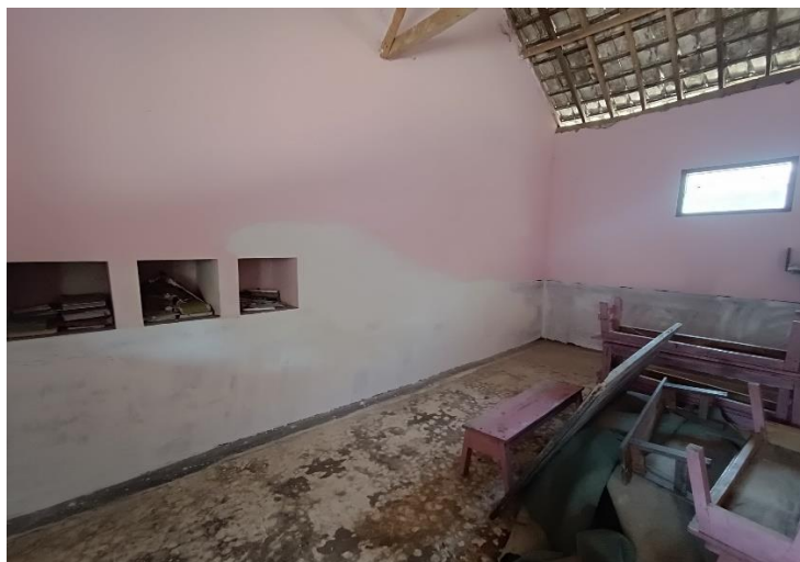
Gambar 1. Kondisi Ruang Belajar Setengah Pengerjaan Perbaikan
